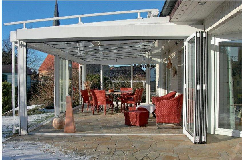
Um zusätzlichen Wind und Wetterschutz zu gewährleisten, können Terrassendächer mit Windschutzelementen, Schiebe- und Faltanlagen unterbaut werden. Somit können sie in Zukunft bei jedem Wetter den Sommer draußen genießen.
