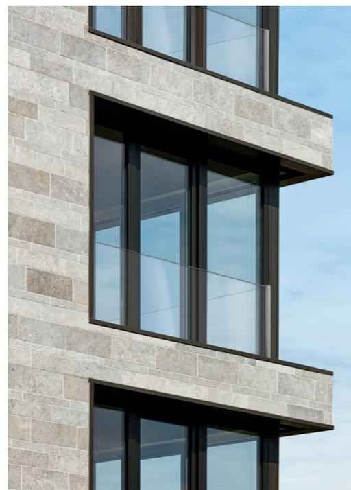
Die Schüco Absturzsicherungen werden am Fensterprofil montiert – eine perfekte Verbindung von Ästhetik und Sicherheit.
